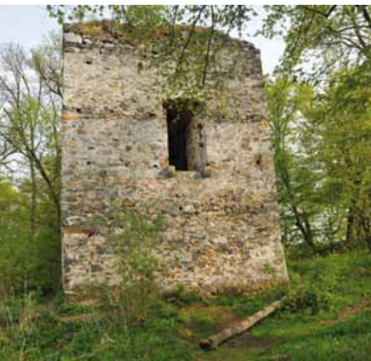
Hláška předsunutého opevnění na kopci / Meldeturm des Vorwerks am Berg (PL)
